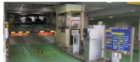
図 3 錦糸町パークタワー入口 (チケットレス対応駐車券発行機)
